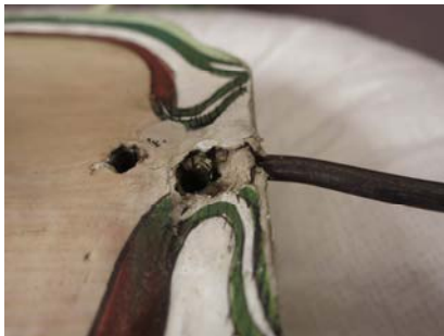
Détail d'une zone d'assemblage avant intervention
